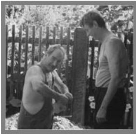
H. Morche und W. Fechner beim Wasserleitungsbau 1998
