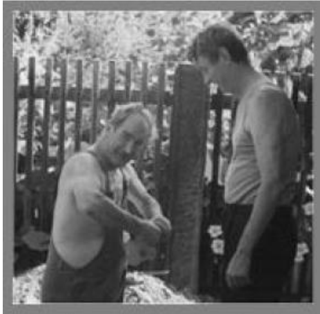
H. Morche und W. Fechner beim Wasserleitungsbau 1998
