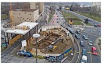
Nur aus der Luft ist die Baugrube vor der Carolabrücke gut sichtbar. Umschlössen ist sie von hölzernen Wänden. Dort wird ein unterirdisches Wehr in einem sogenannten Trenn- und Steuerbauwerk errichtet. Foto: Bpa/WZ
