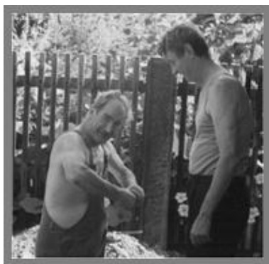
H. Morche und W. Fechner beim Wasserleitungsbau 1998
